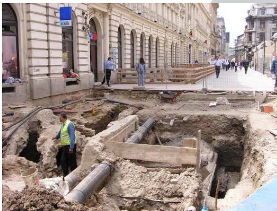
Lucrari de reabilitare infrastructura cu afectarea rețelilor de alimentare cu apa si canalizare pe str. Lipsani.
